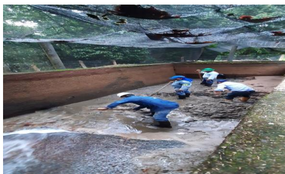
Registro fotográfico: Mantenimiento sistema de captación y desarenador vereda La Motuz
